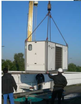
oude Cliref chiller 1997
