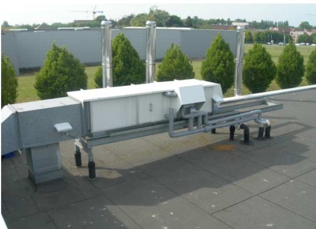
vernieuwen sturing en voorverwarmingsbatterij CV (verse lucht)
