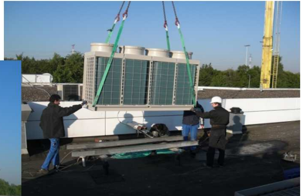
plaatsing nieuwe chiller met torenkraan
